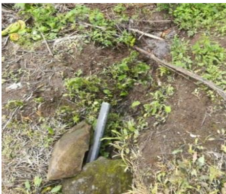
Foto 1: Aguas servidas. Fuente: autor
