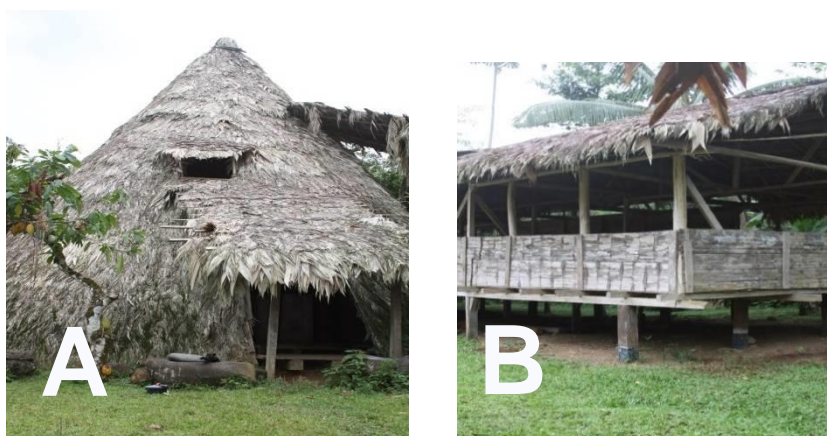
Figura 1. Tipos de estructuras de los albergues turísticos en territorio indígena bribri. (A) Estructura cónica en Alto Katsi 2014 (B); Estructura rectangular sobre pilotes en Kachabri 2013.
