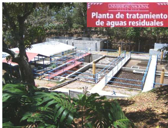
Foto 3. Planta de tratamiento de aguas residuales del Campus Presbítero Benjamín Núñez
